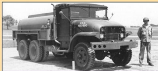
◀ en ▲ M217 Truck, Gasoline Tank. Er waren slechts enkele kleine uiterlijke verschillen met de M222 Truck, Water Tank ▼
