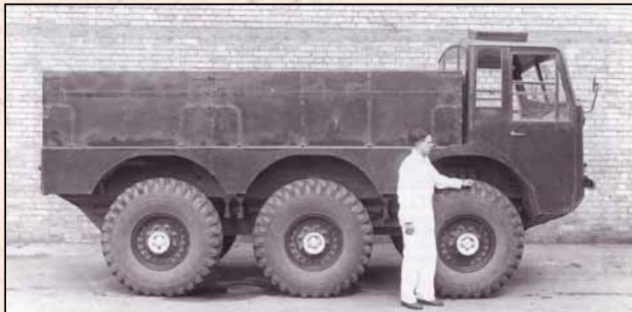
De PV1, het eerste prototype van de Stalwart, was gebaseerd op onderstel van het Salamander brandweervoertuig, dat de motor achterin had en niet amfibisch was.
